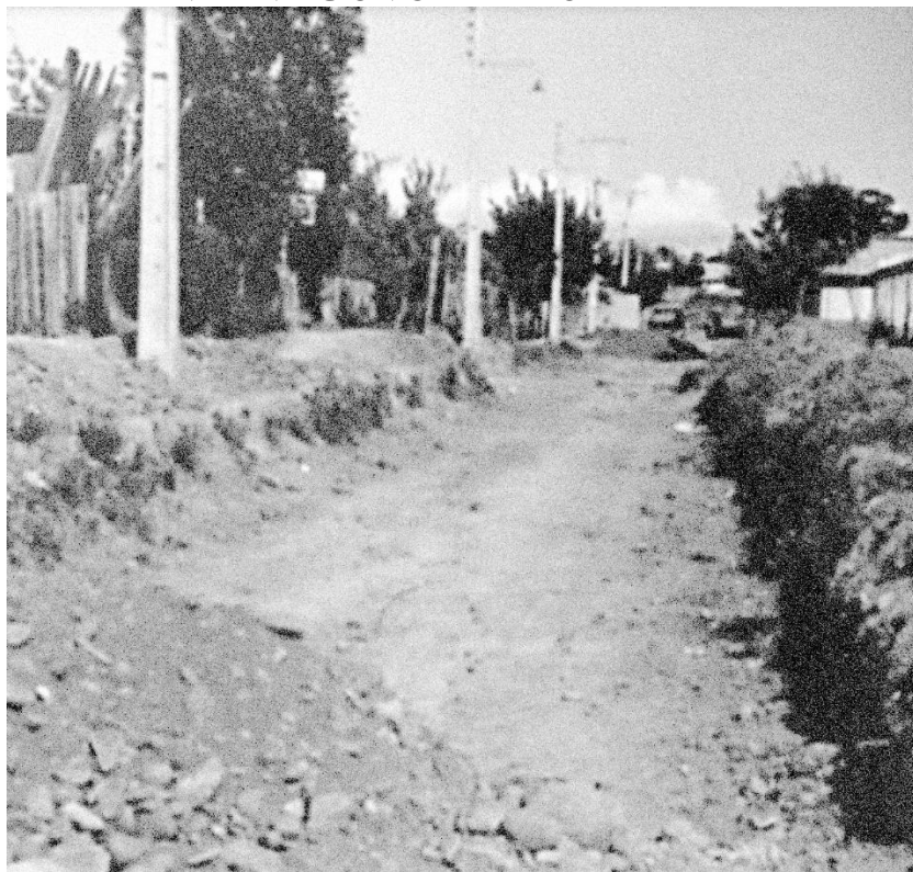
FIGURA 13. PRIMERA PAVIMENTACIÓN DEL BARRIO.
