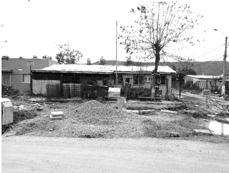
FIGURA 47. TRABAJOS DE PAVIMENTACIÓN.
