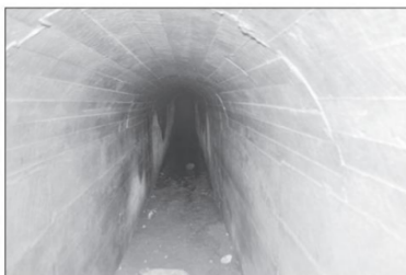
El acueducto mide aproximadamente 27 metros de largo, un metro 75 centímetros de alto y es de hormigón armado.
